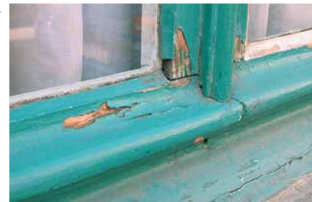
1. Calage d'un vitrage. 2. Renouvellement du mastic. 3. Pointes, marteau de vitrier et couteau à mastiquer. 4. Entrée d'eau dans un assemblage et soulèvement de la peinture.
